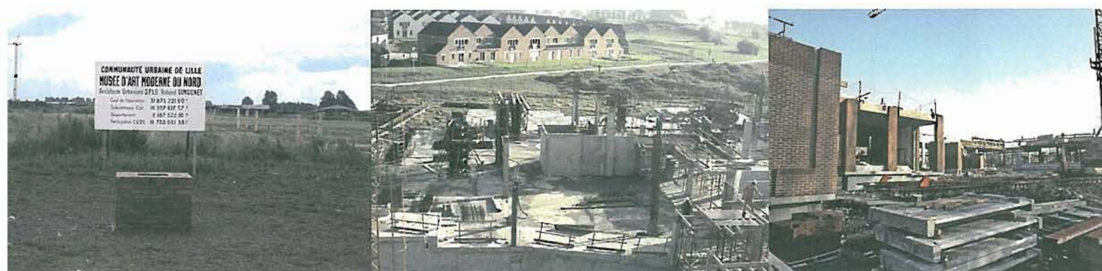
Vues du chantier du musée, 30 juillet 1980 et 4 novembre 1981
