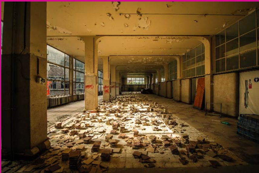
ROTOR, démontage de sols conçus en 1937 par Joseph Moutschen- pour l'Université de Liège pour le campus Val Benoît. © SPI- Olivier Béart - www.valbenoit.be
