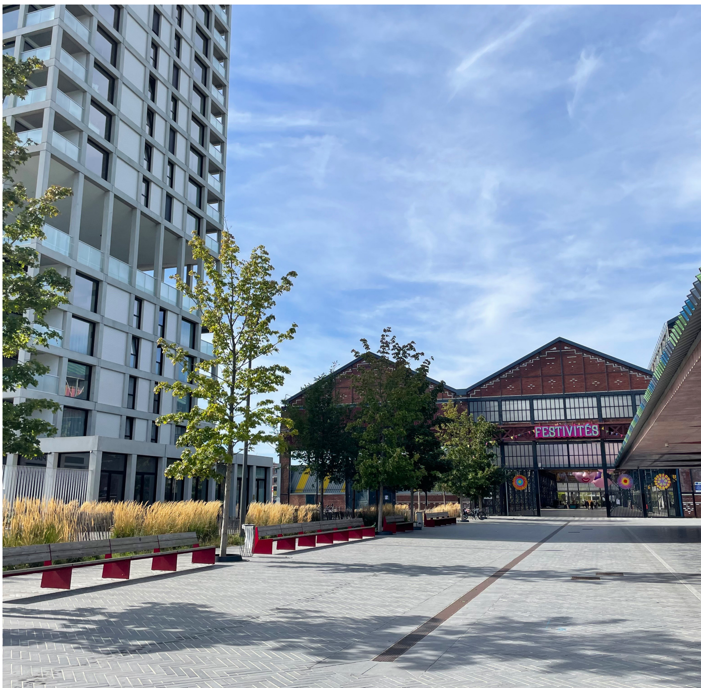
Entrée du passage de l'International, Fives Cail, 2025, R.Wormser
