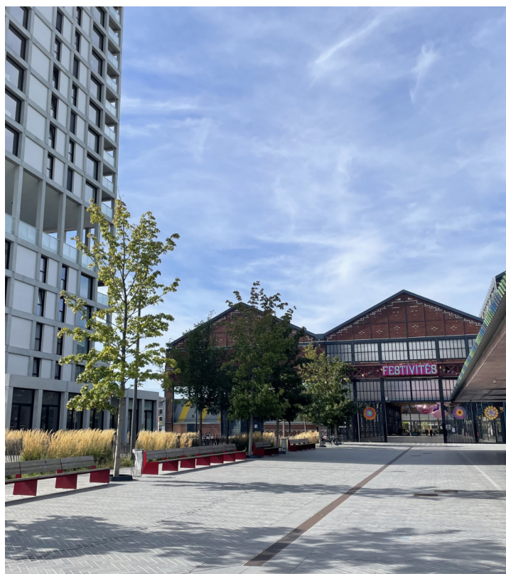
Entrée du passage de l'International, Fives Cail, 2025, R.Wormser
